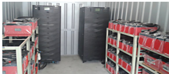
Locação de equipamentos p/ o Sambódromo de São Paulo
